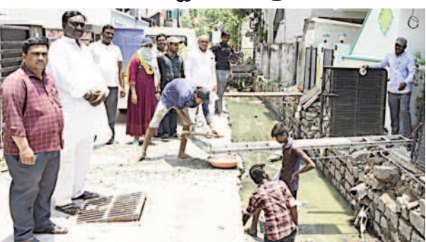
బాక్స్ డ్రైన్ పనులను పరిశీలిస్తున్న కార్పొరేటర్ ప్రేమ్‌కుమార్ తదితరులు
